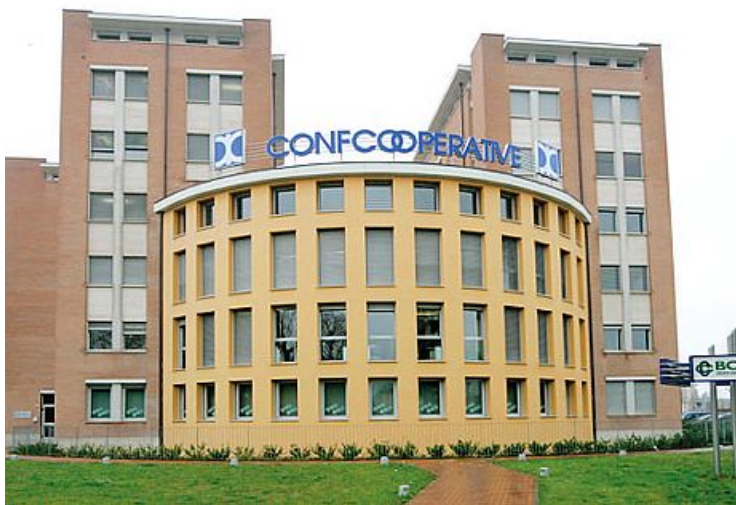
Il convegno si terrà nella sede di Confcooperative in Largo Gerra
